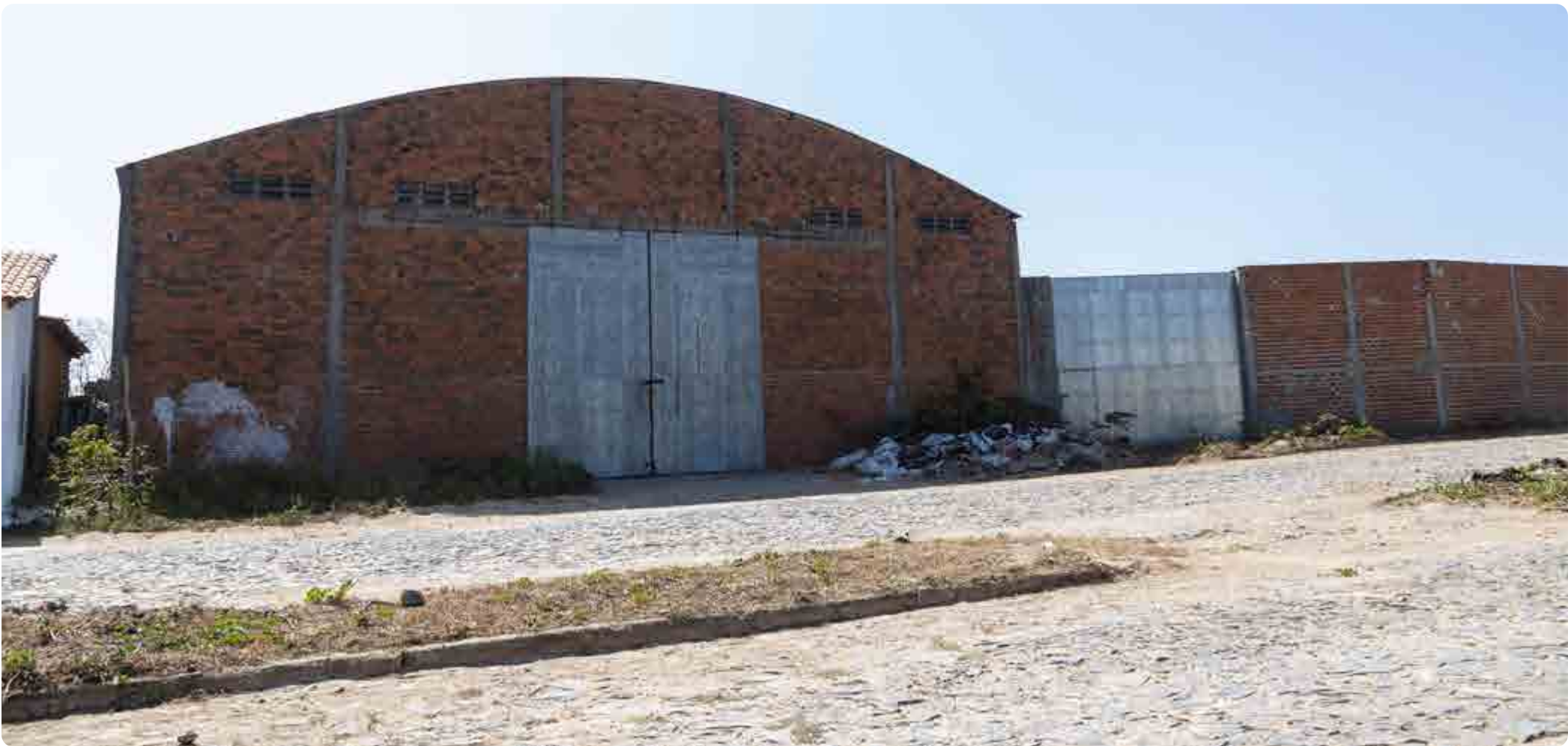
Figura 10 Fachada do galpão construído em uma porção da área cuja vegetação foi suprimida.
