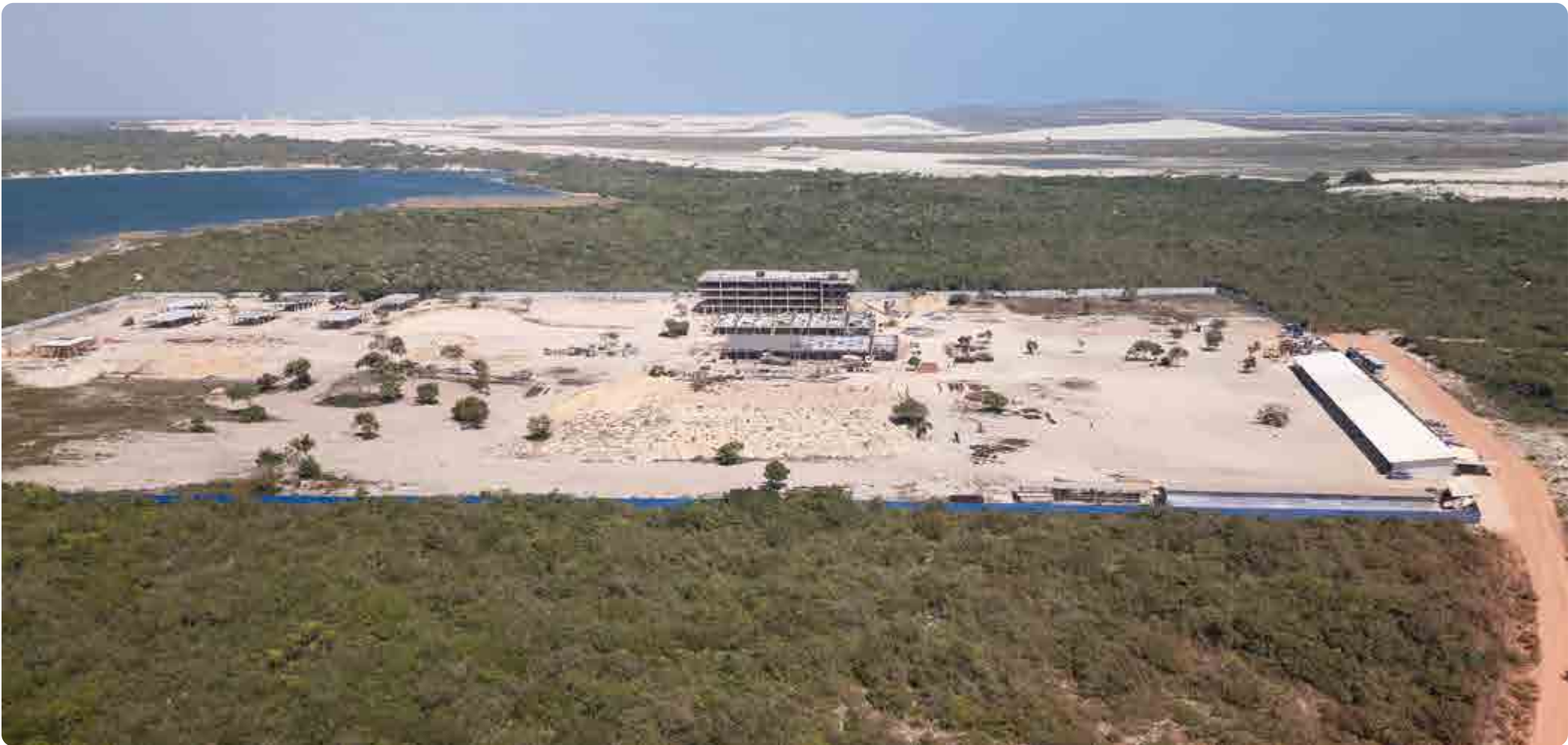
Figura 2 Resort em construção na área onde foram suprimidos 11 hectares de restinga, entre 2023 e 2024, em Cruz (CE). À esquerda, a Lagoa de Jijoca; ao fundo, as dunas do Parque Nacional de Jericoacoara.
