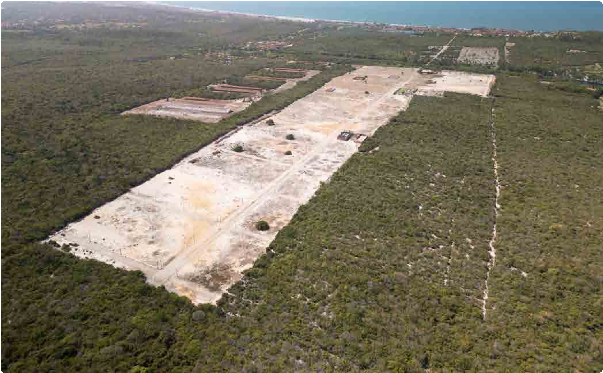
Figura 18 Área de 3 hectares que se integra a área maior destinada ao loteamento.
